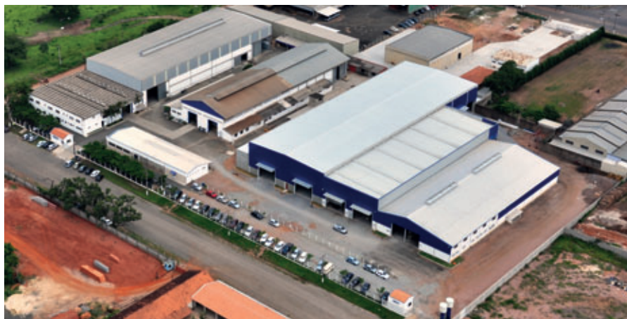
Sede da empresa de WCH – Weiler-C. Holzberger Indl. Ltda. em Rio Claro, Brasil
